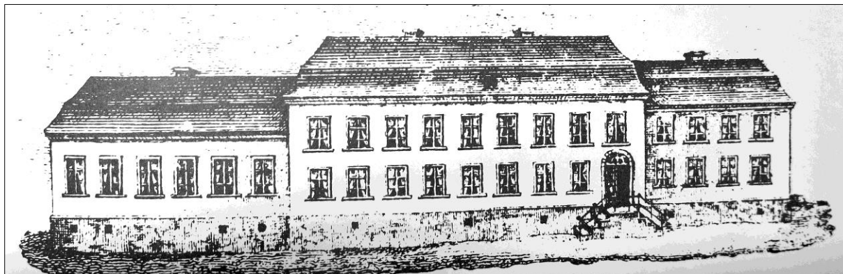
Hotell Stadshuset på Kungsgatan mitt emot klocktornet. I hotellets stora salong spelade ofta resande teatersällskap teater under andra halvan av 1800-talet. Byggnaden revs 1906 och Stadshotellet byggdes på samma plats. Bild: Karlshamns museum
