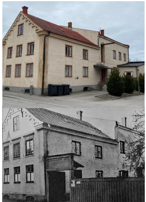
Den gamla punschfabriken och sedermera Äggcentralen idag och på 1940-talet.
